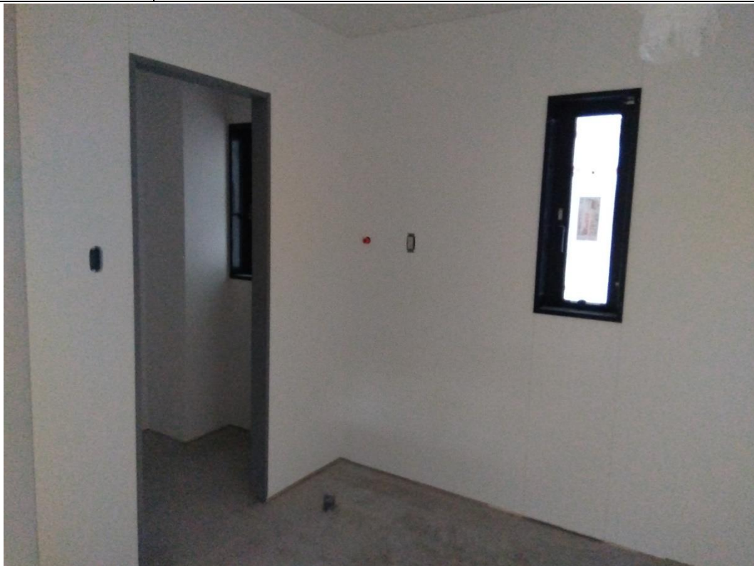
令和 7 年 9 月 1 8 日現在の脱衣室・シャワー室の状況
