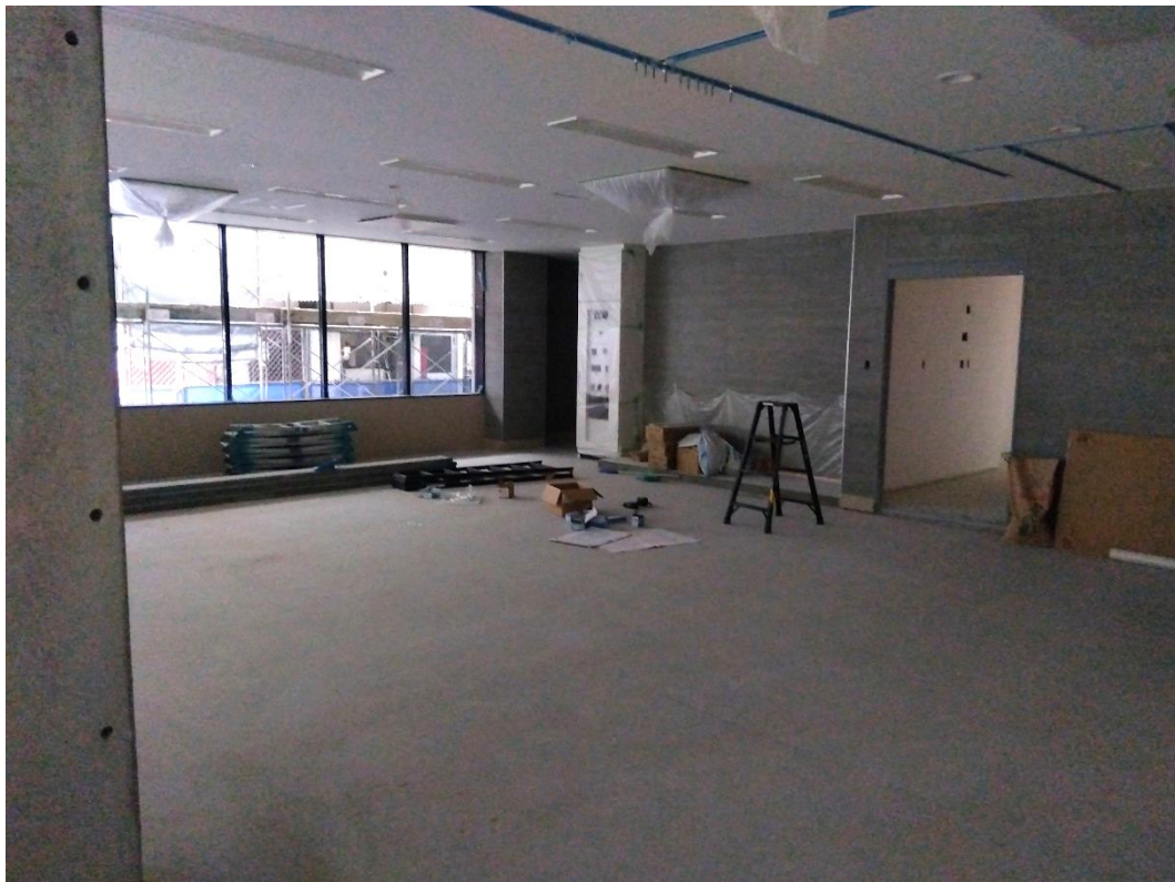
令和7年9月18日現在の執務室の状況（トイレ側から撮影）
