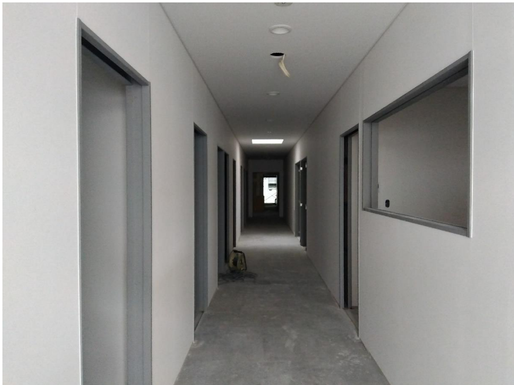
令和7年9月18日現在の待機室前通路の状況
