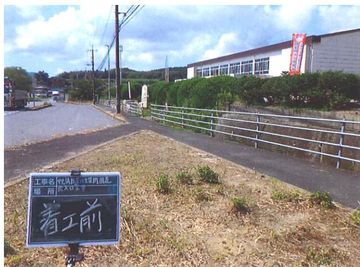
着工前（令和6年9月）
