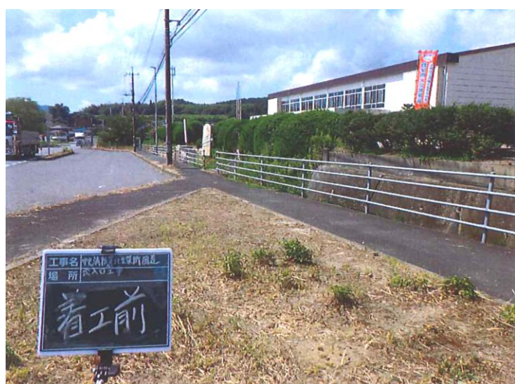
着工前（令和6年9月）
