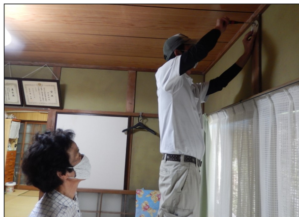
住宅用火災警報器の設置風景
